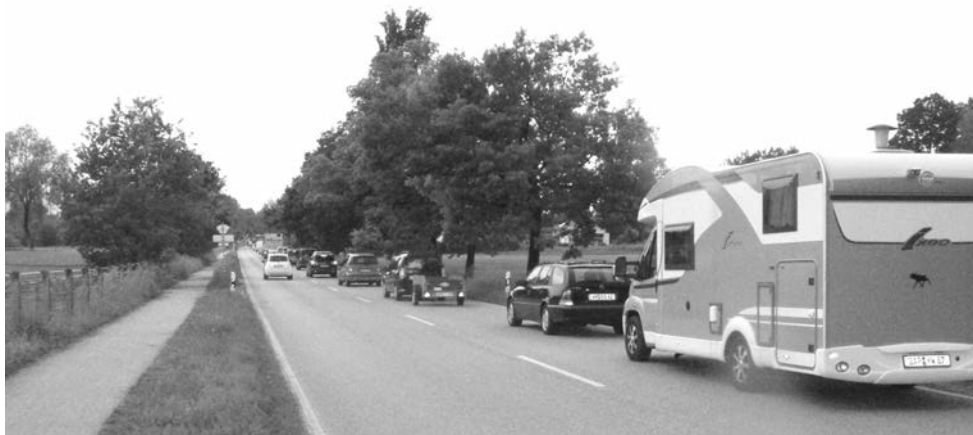
Das Foto wurde an einem Samstagvormittag (28. Mai 2011) an der B 472 in der Nähe des Gasthauses Moosmühle aufgenommen. Der Rückstau vor der geschlossenen Bahnschranke war zirka 650 Meter lang, die Wartezeit betrug mindestens 10 Minuten. Grund ist meistens die Verspätung eines Zuges, der auf der eingleisigen Strecke im Bahnhof Huglfing warten muss. Bei Zügen aus Richtung Garmisch sind die Schranken nur 40 Sekunden geschlossen, wenn kein Gegenzug erwartet wird.
